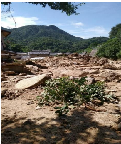
【植木も埋まる高さの土砂】
